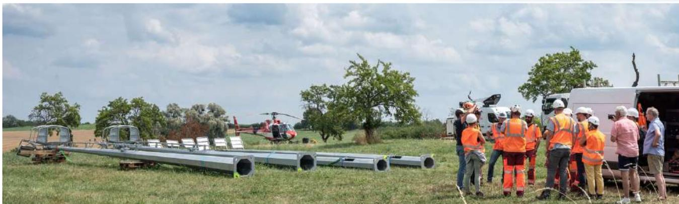
Le 15 juillet 2025, un hélicoptère de type "Écureuil" est venu au stade pour héliporter les quatre pylônes d'éclairage entreposés dans le champ qui jouxte le stade, en vue de leur fixation au sol sur les massifs bétons réalisés lors des travaux.
