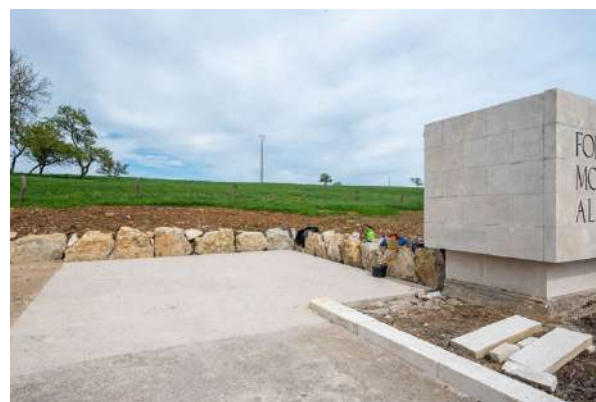
Enrochement et réalisation des deux places de parking pour les personnes à mobilité réduite à gauche du monument.
